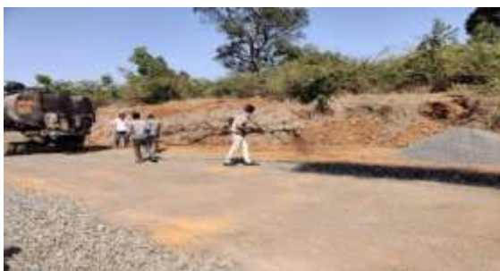
Fig 3. Bitumen spray
