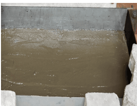
Ferrocement bottom layer
