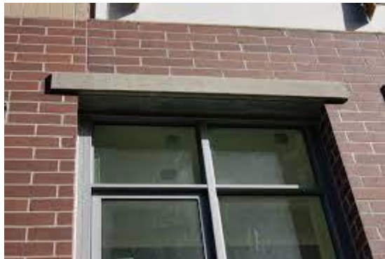
Fig. 3.10. Prefab Lintel
