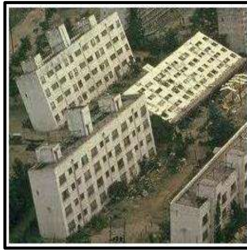
(d) Niigata Earthquake
